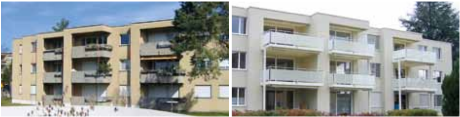
Mehrfamilienhaus Baujahr 1972, Energiebezugsfläche EBF 1015m 2 Energiekennzahl: 908 MJ/m 2 , 9 Wohnungen, Ölheizung
